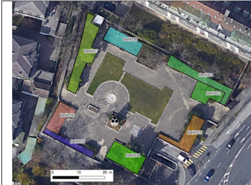
Jardin-toiture de Bellefontaine (8 secteurs) 1
