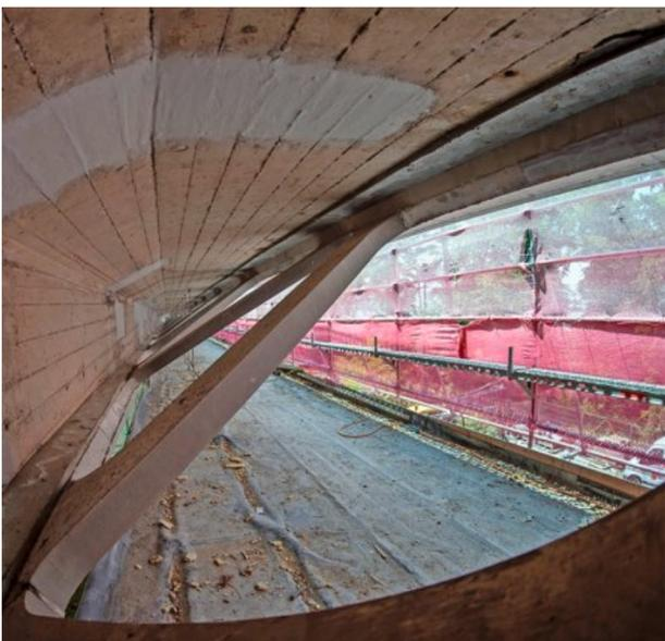
Sur les bords de la chaussée, des béquilles en béton soulagent désormais les porte-à-faux.
